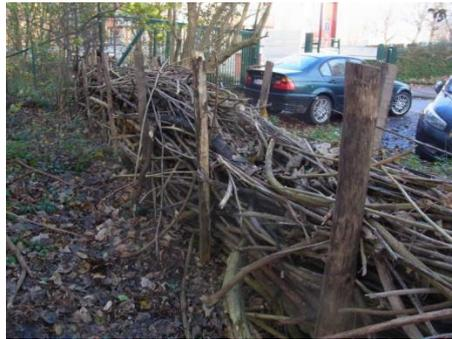
5.4.2. Les Plantations planteront des piquets de 1m (partie dépassante : 60 à 80cm) en double rangée ; espacement : 50cm entre rangées et 2m entre piquets, en alternance ; les AdS rempliront avec des branches mortes.
